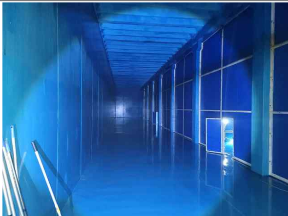
배수지 1지 내부 전경
