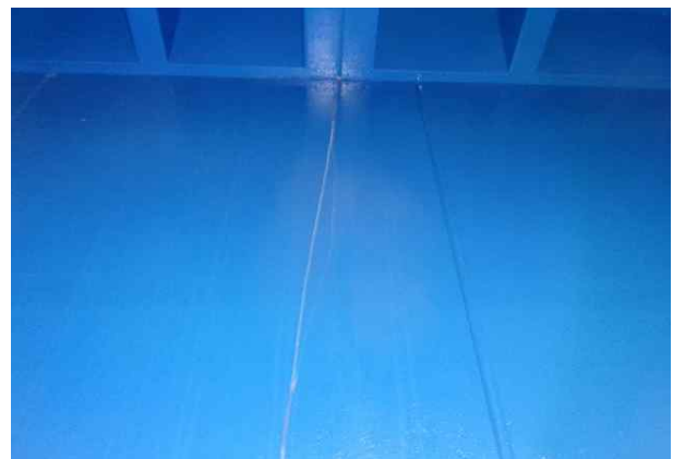
손상내용 유출밸브실 벽체 백태 손상원인 외부 우수유입
