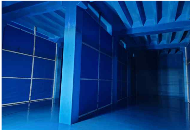
손상내용 1지 기둥 상태양호
