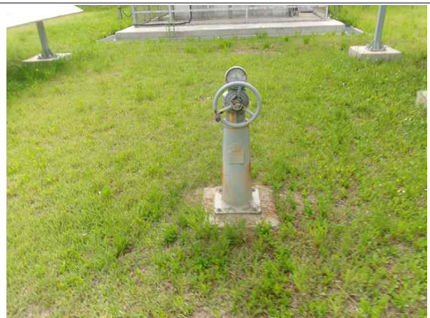
배수지 상부 현황
