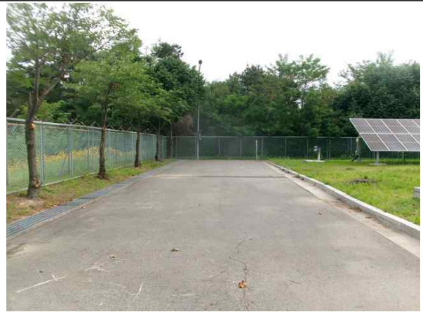
진입로 포장 현황
