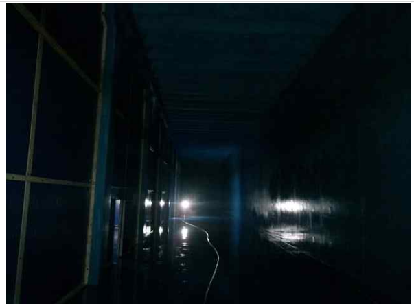
배수지 2지 내부 전경
