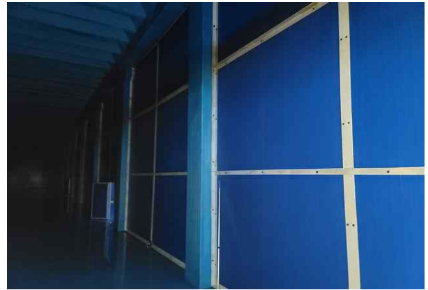
손상내용 1지 벽체 상태양호
