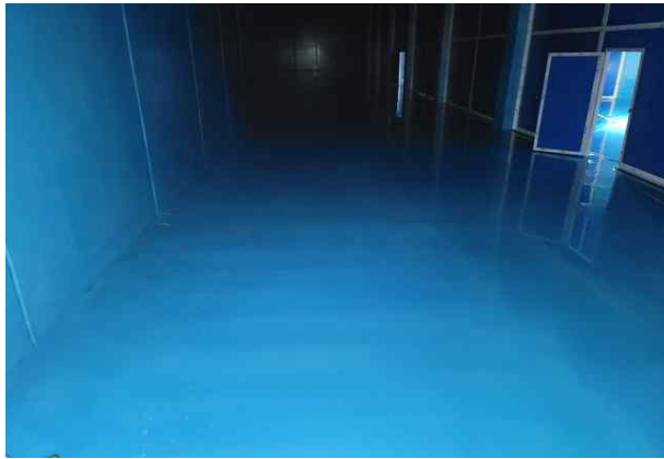
손상내용 1지 하부슬래브 상태양호
